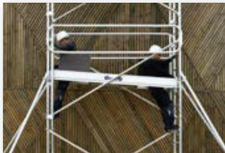
✓ **ÉCHAFAUDAGE ÉQUIPÉ DE PLANCHERS ALTO (2 trappes + plinthes intégrées).**
